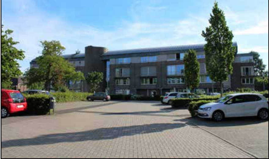
Het dak van het gebouw van de assistentiewoningen zal worden vernieuwd.
