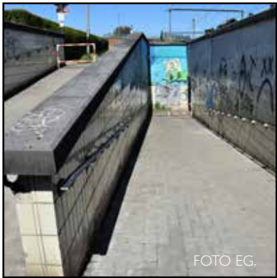
De Foksveldtunnel moet worden vernieuwd en verruimd
